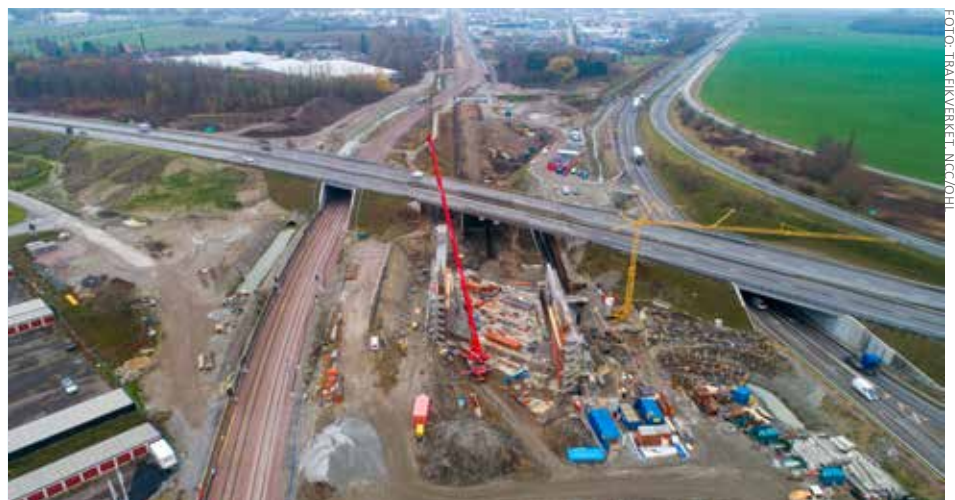
Trafikverket bygger fyra spår mellan Malmö och Lund. Här vid trafikplats Alnarp.
