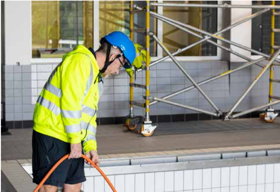
Patric Andersson, fastighetstekniker på badet, kikar ner genom en lucka på det första rinnande vattnet i Burlövsbadets bassänger.
